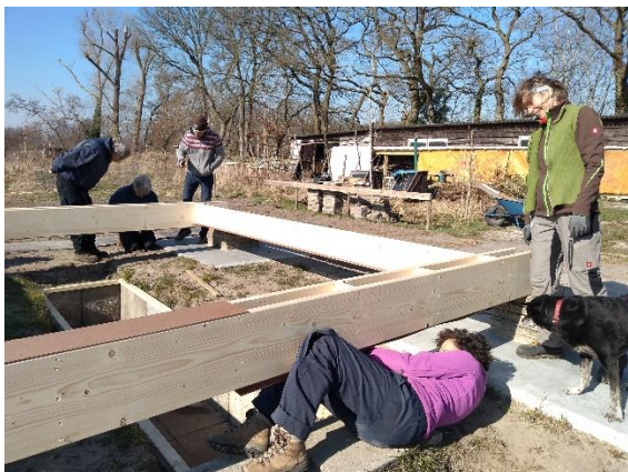
Vrijwillige bouwer Nicole schroeft hardboard stroken onder de vloerbalken van de eerste cel.
