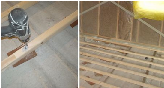
Figuur 3-2 betonnen kanaalplaatvloer met houten latten daarop geschroefd. Bron: Maarten Wiersma
